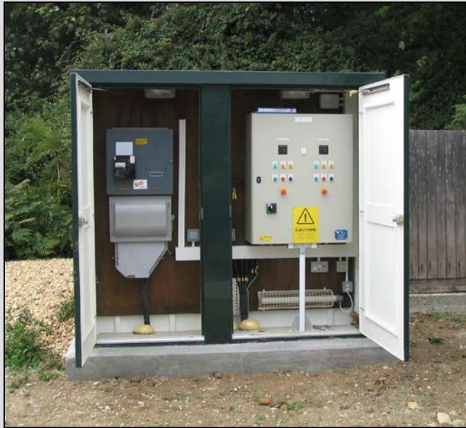
Verteilkaste für das Ansteuern der einzelnen Pumpen
