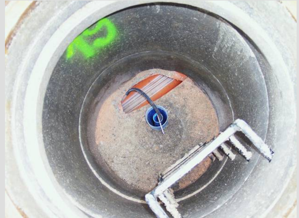
Blick in einen Drainageschacht
