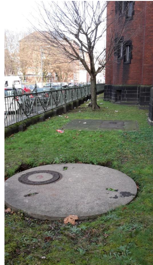
Blickrichtung Norden Fernwärmeschacht
