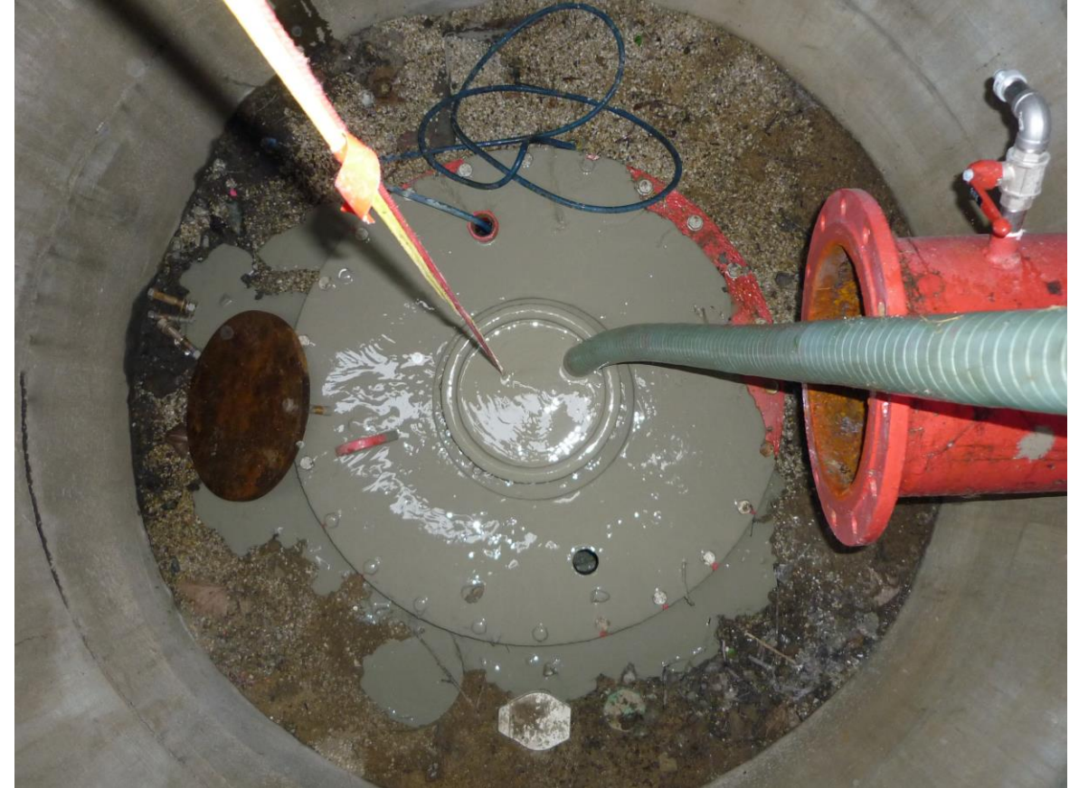
Sprengverpressung mit Brunnendämmer
