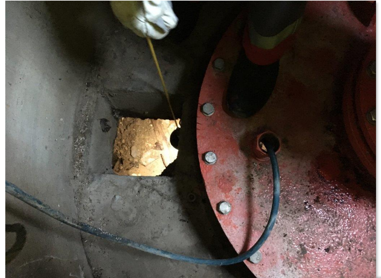
Blick durch den Brunnenstubenboden
